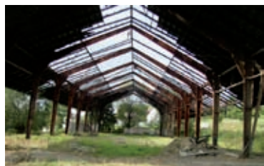
Ocelová konstrukce haly Val. Meziříčí
