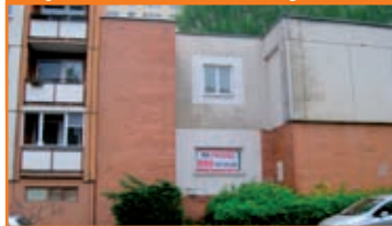
Ubytovna Zlín - Jižní Svahy N04715
